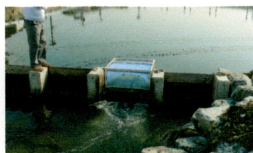
設置されたトラップ
